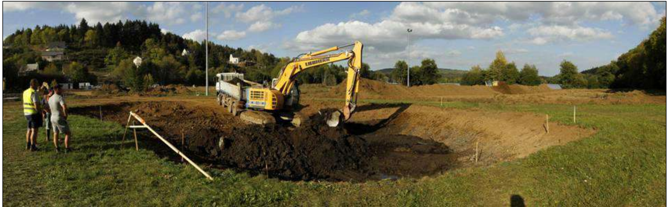
Terrassement de la zone humide
