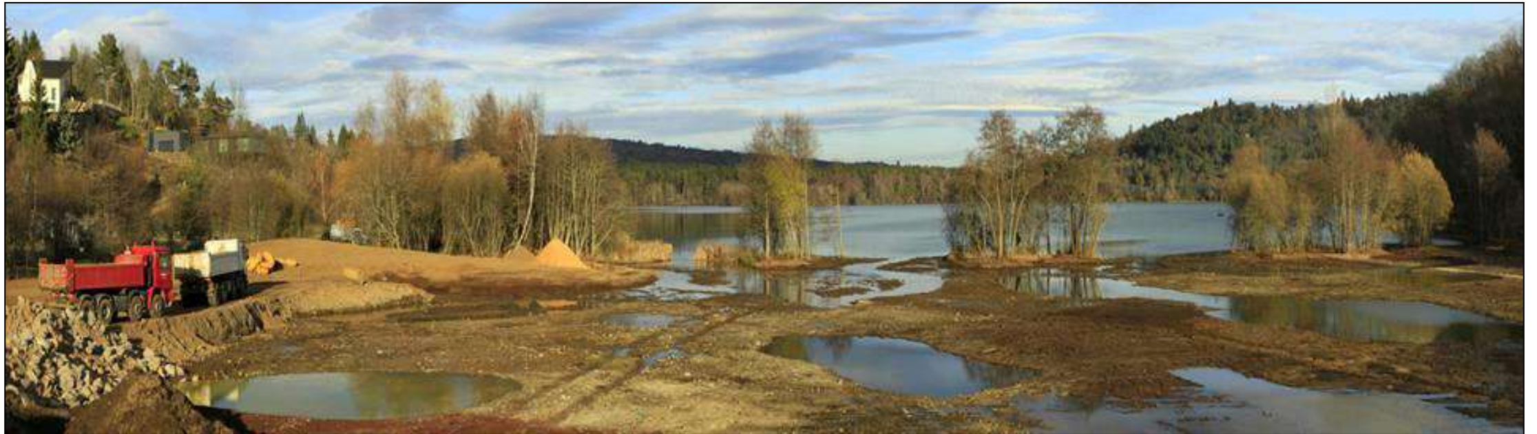
Terrassement de la zone humide
