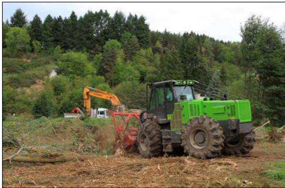
Nettoyage de la végétation
