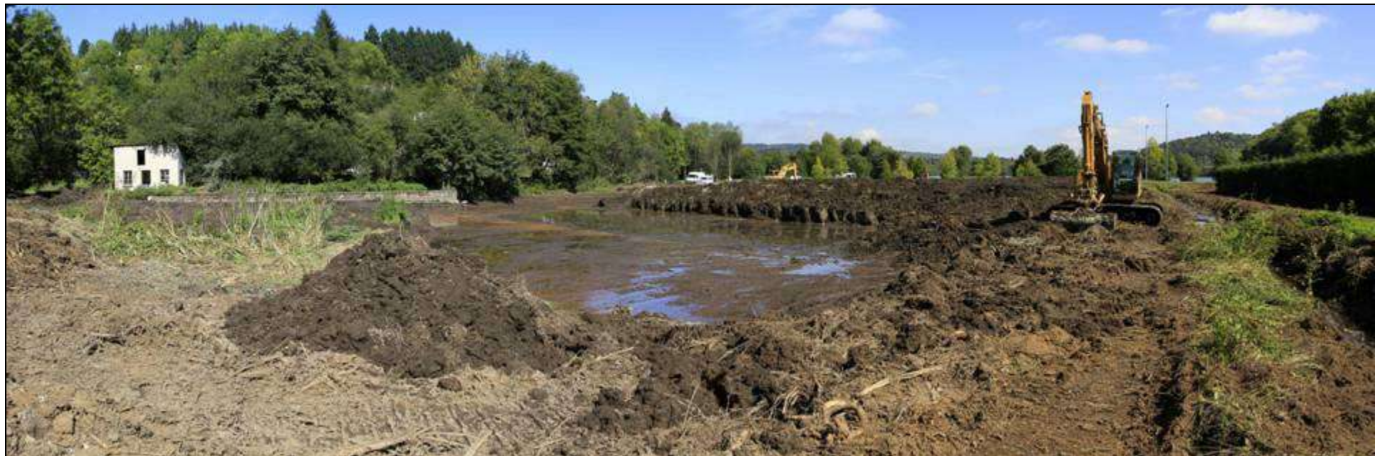
Curage des bassins
