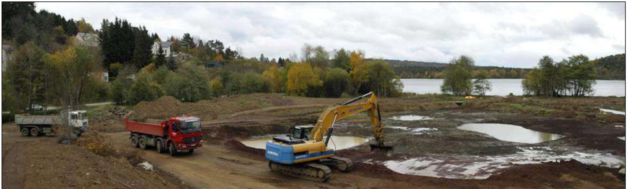
Terrassement de la zone humide
